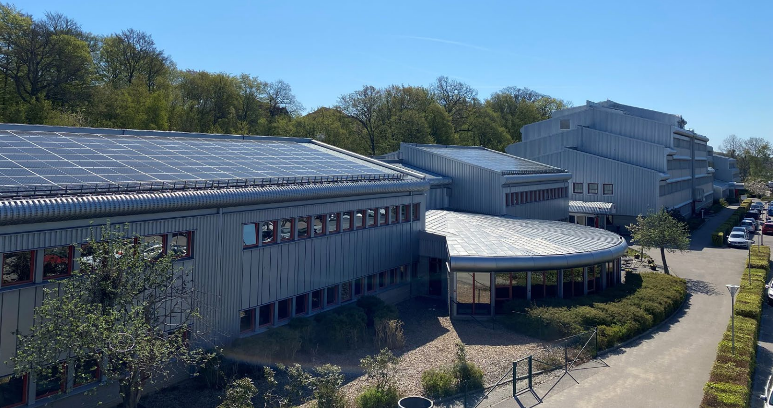
Solcellerna på Soft Centers tak genererade 284 kWh under 2025, motsvarande knappt 25% av anläggningens totala elförbrukning.
